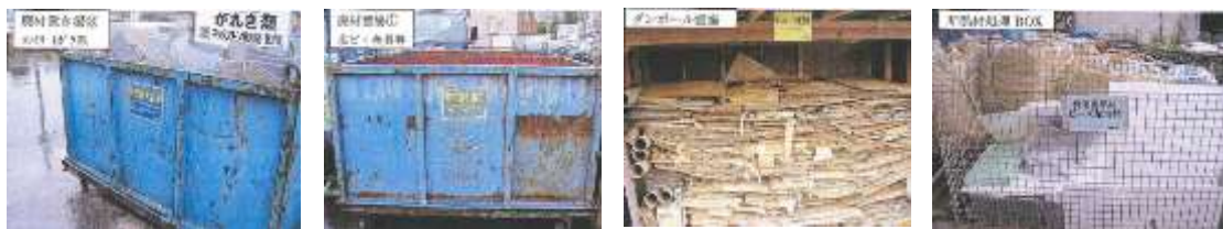
廃棄物処理方法の徹底を図る為、コンテナボックスに処分ゴミの種類を表示
