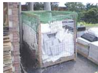
強風時のゴミの飛散防止 対策としてネットを取付け
