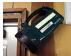
(禁煙表示・消火器・懐中電灯)
